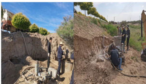
图2 獾洞开挖、灌浆处理完毕以及回填完毕
