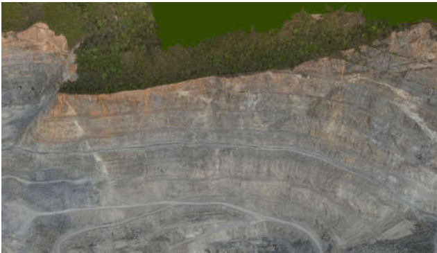
图1 东采区上盘边坡影像图
