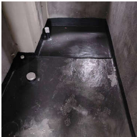
现场防水施工后照片
