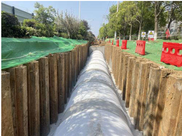
管道固定和支撑图
